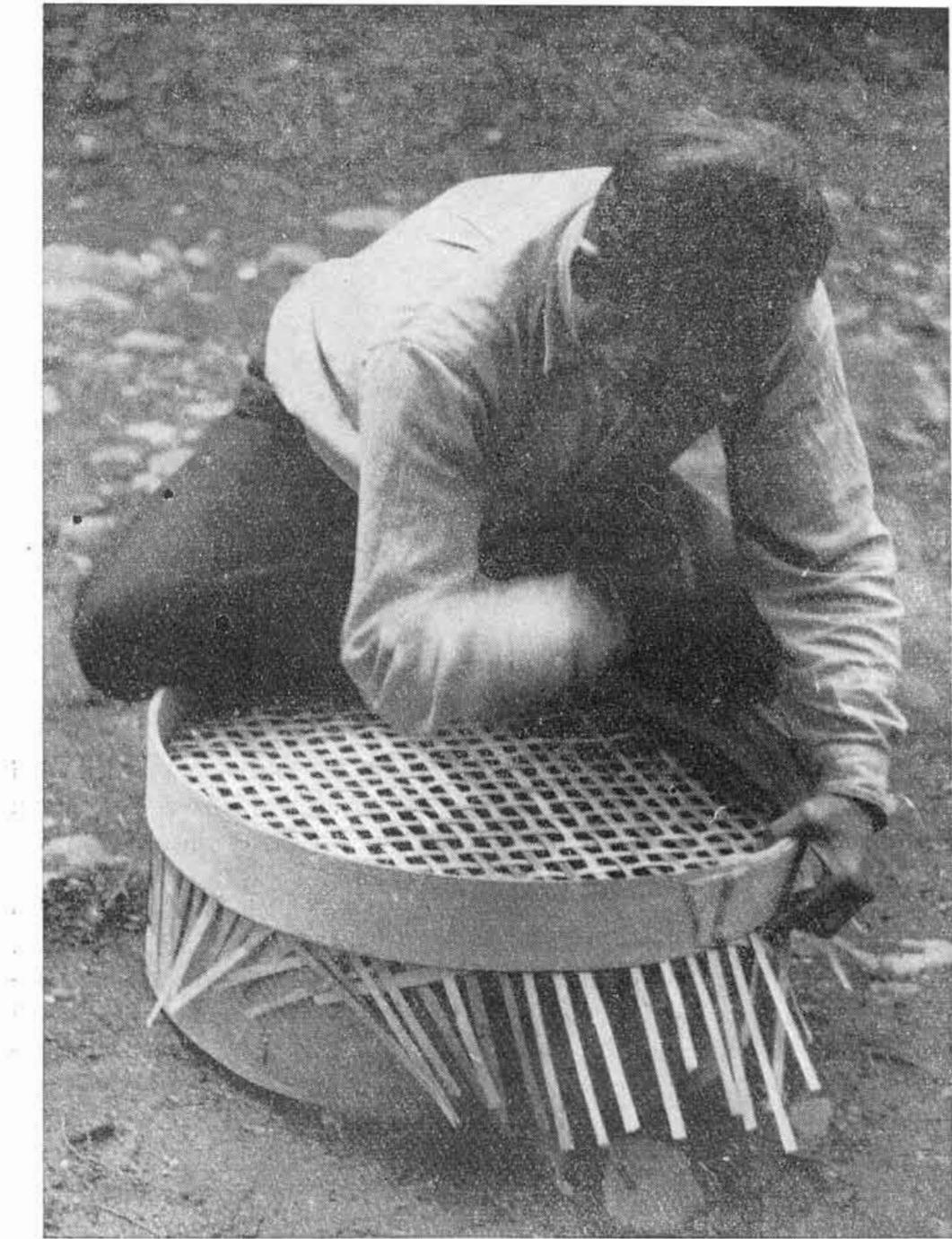
Obr. 19. Nasadzovanie úzkeho (spodného) luba na lykové dno, zhotovené pletením zo širokých (lieskových) lubkov. Jasne vidieť presahovanie jednotlivých lubkov cez okraj i jeden stred pletenia, na ktorom sa lieskové lubky pred zhotovením okrutky vyrežú.
